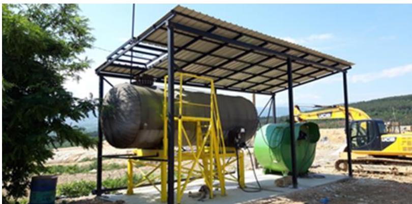
Слика бр.V-7: Пумпа и резервоар за гориво Д2
